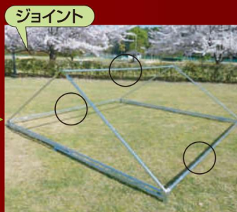
2つのパーツをおこし桁、棟パイプを差し込みます。
